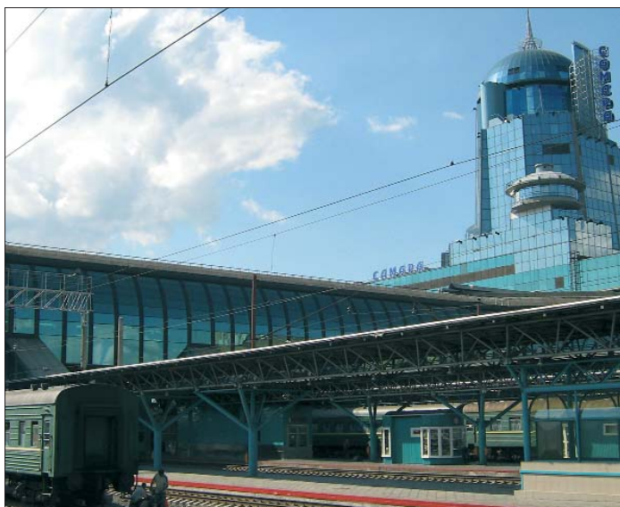
Железнодорожные пути перекрыты конкорсом на восьмиметровой высоте, где размещен комфортабельный зал ожидания, соединенный с платформой лестницами и лифтами
