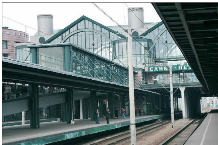
Вид на Ладожский вокзал со стороны платформы
