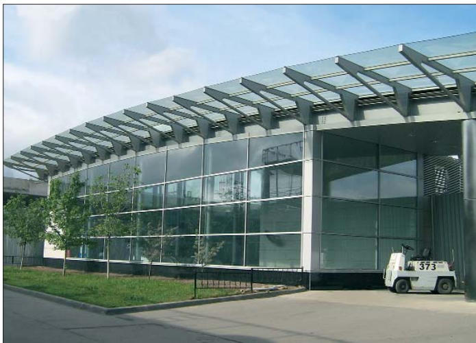
Наземный павильон подземной станции в аэропорту Внуково
